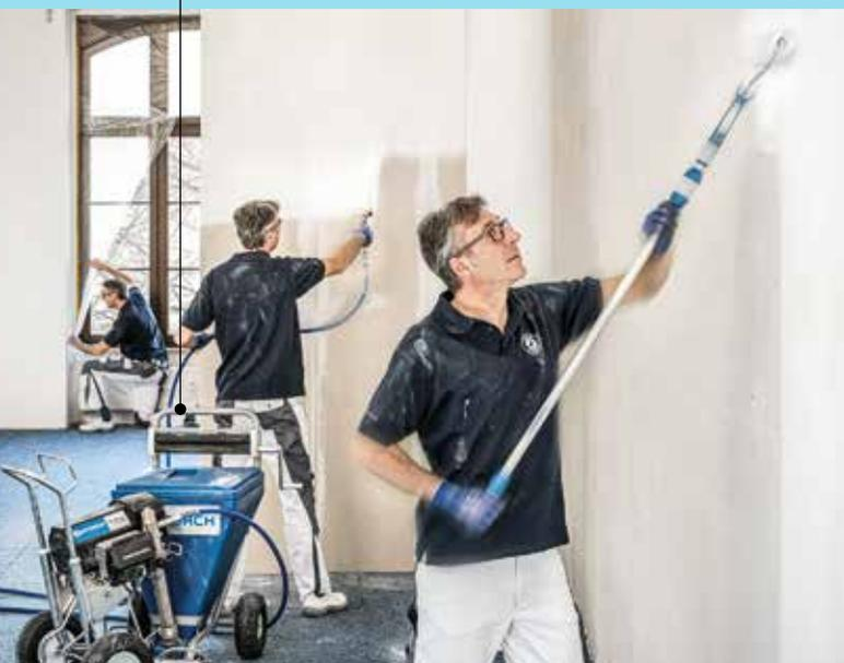
Das robuste und leistungsstarke Kraftpaket für größere Renovierarbeiten, Neubauten, Mittel- und Großobjekte und die rationelle Verarbeitung von nahezu allen airlessverarbeitbaren Materialien. Einsetzbar im Dispersionsbereich und perfekt geeignet für die Verarbeitung von Spritzspachtel, ideal in Kombination mit Spachtelbehälter inkl. Sackmangel (Art.-Nr. 69 60 20).
